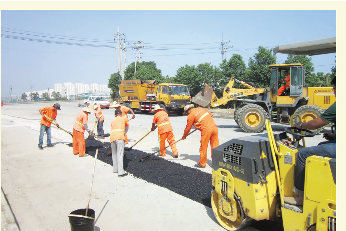
9月16日清晨,锡山区大成工业园区内机声隆隆,锡山区公路管理处养护部门正对前期因铺设燃气管道开挖后的路面实施沥青摊铺,以恢复路面的完好,使园区道路在节日来临前有一个良好的通行环境。(缪小兵)
