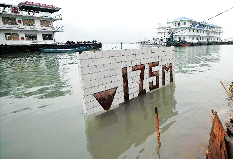
26 日 9 时，三峡水库水位涨至 175 米，首次达到工程设计的最高蓄水位。自此，三峡工程的各项功能都可达到设计要求，其综合效益可全部发挥。
