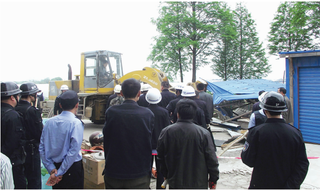
云林街道违法建设拆除现场
