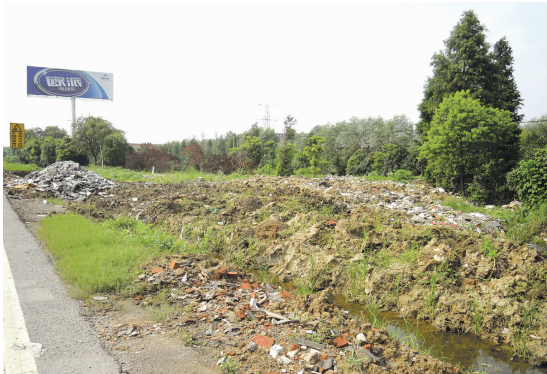
312国道两侧绿化整改前
