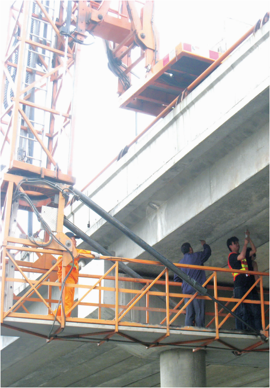
桥梁结构检测
